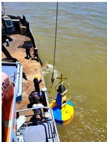
Instalación de la Boya de Peligro Reciente en la zona donde se encuentra la obstrucción a la navegación
